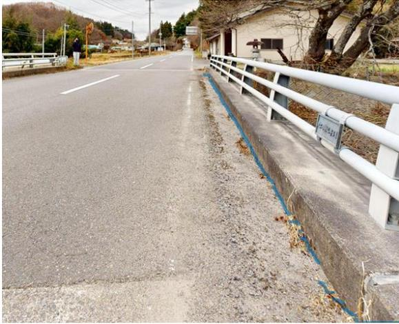
図-12 DeepLabv3+を利用したセマンティックセグメンテーションや Segment Anything Model (SAM)で領域の境界を調整した結果を利用し、地覆と道路面の境界を抽出した時の例。
