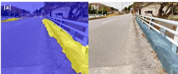
図-11 [a] Deeplabv3+を利用したセマンティックセグメンテーションの結果. [b] Segment Anything Model (SAM)で領域の境界を調整した時の様子.
