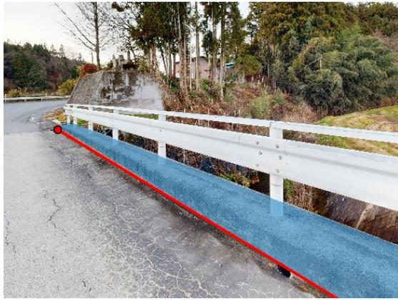
図3 本研究にてセグメンテーションする対象である地覆および地覆と道路面の境界
