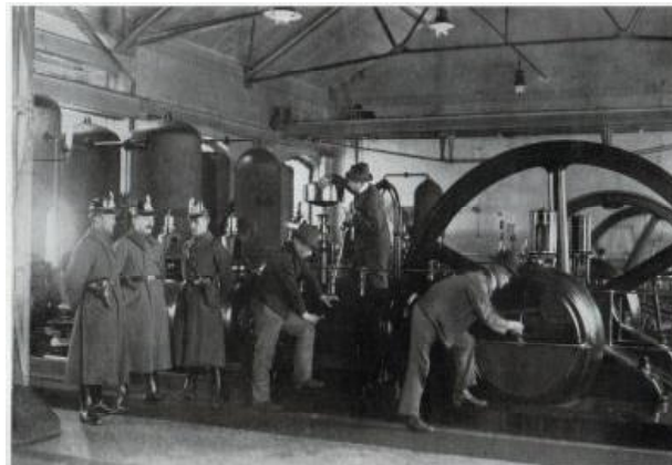
生活上重要な機械の臨時補修
