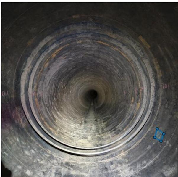
図-2 対象の導水路トンネルにおける錆の領域を手動で選択している様子。
